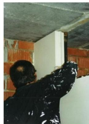
Les réparations éventuelles sont réalisées au moyen d'un mélange de plâtre et colle. Afin de permettre la stabilisation des planchers et des cloisons, on referme le joint supérieur de préférence après la mise en charge total des dalles.
