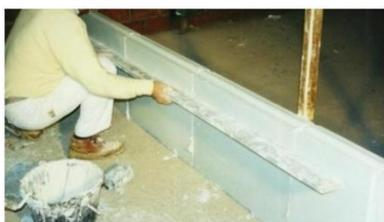
Ils doivent être parfaitement bien emboîtés de telle sorte que la colle reflue hors des joint. Le dernier bloc est coupé à mesure. Avant d'entamer la pose du deuxième rang, il y a lieu de vérifier la pose de ce premier rang avec une règle et de faire les corrections éventuelles.
