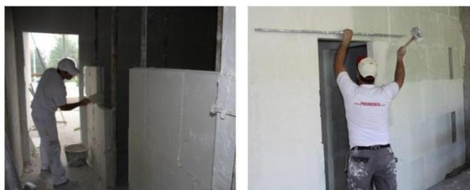
L'emboîtement spécial des blocs de plâtre Promonta permet au surplus de colle retenu entre le tenon et la mortaise de refluer entre ces derniers (la mortaise étant légèrement plus profonde que le tenon). Après la pose de chaque rang, il y a lieu de contrôler la planéité de l'ensemble.
